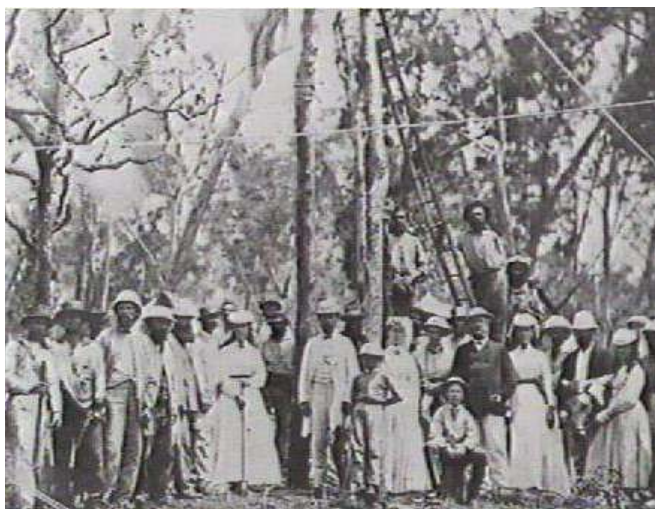
Рис. 2. Установка первого столба трансконтинентальной австралийской наземной телеграфной линии в Дарвине, 1870 г.
