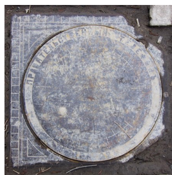
Рис. 11. Люк телефонной канализации в Саратове.
