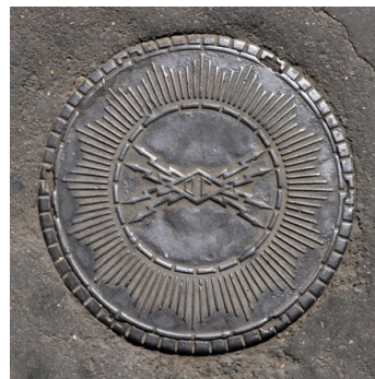
Рис. 15. Люк телефонной канализации в Одессе.
