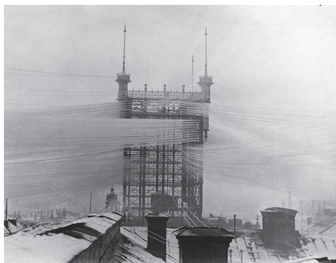
Рис. 2. Телефонная станция в Стокгольме, 1890 г.
