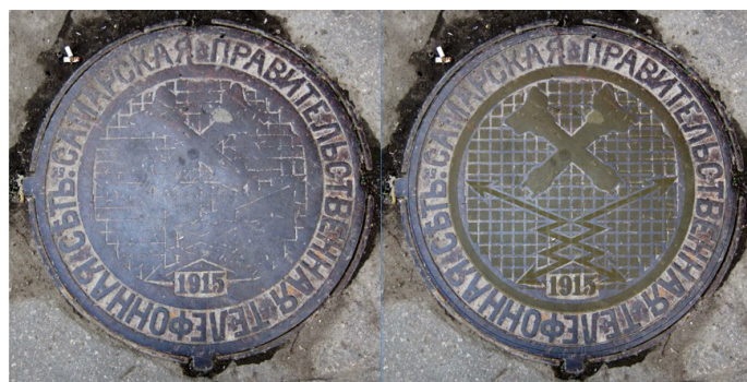
Рис. 10. Люки телефонной канализации в Самаре.
