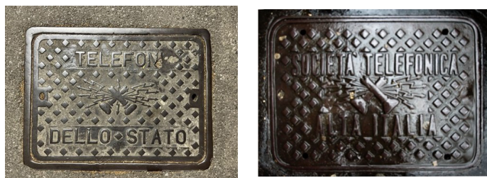
Рис. 12. Итальянские люки телефонной канализации.
