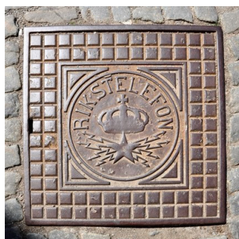
Рис. 13. Люк телефонной канализации в Стокгольме, середина XX века.
