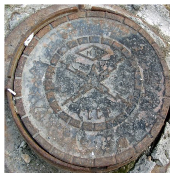
Рис. 16. Люк телефонной канализации в Хабаровске.
